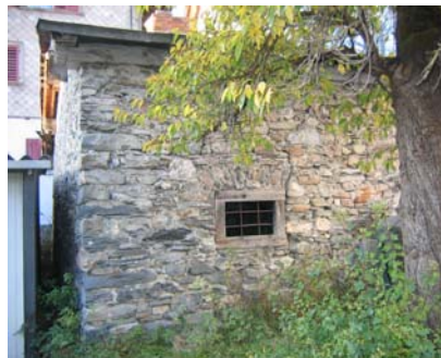
Eingangstür und Fenster mit gemauerten Stürzen
