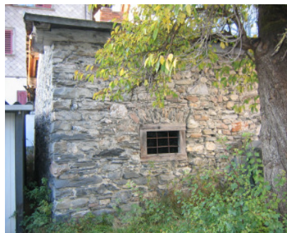
Eingangstür und Fenster mit gemauerten Stürzen
