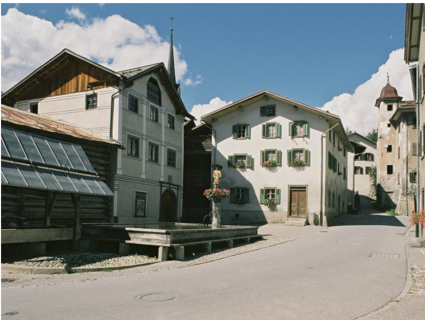
Der Dorfplatz von Valendas mit dem grössten Holzbrunnen der Schweiz ist ein wichtiger Bestandteil des Ortsbildes von nationaler Bedeutung. Links das Grauhus, in der Mitte das Engihus und im Hintergrund das Türralihuus
