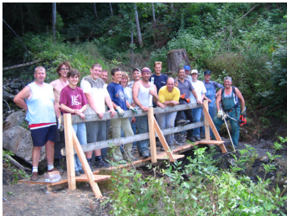
Die neu erstellte Brücke am Rütland-Wanderweg besteht die Belastungsprobe.
