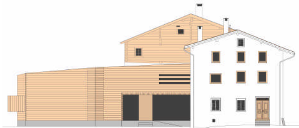
Südfassade des Engihus mit angebautem Saal (Machbarkeitsstudie Architekturbüro Capaul und Blumenthal, Ilanz)
