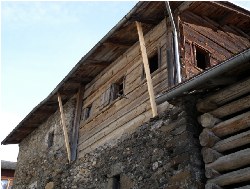
Provisorische Sicherung der beschädigten Dachpfosten.
