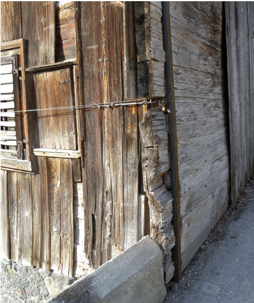
Sicherung der Strickwand an der Freisergasse.
