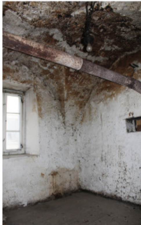
Gewölbezimmer vor und nach der Renovation
