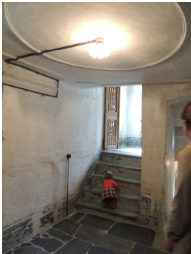
Treppenhaus im Originalzustand
