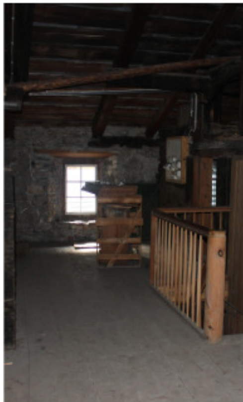
Gang im 2. OG vor und nach der Renovation
