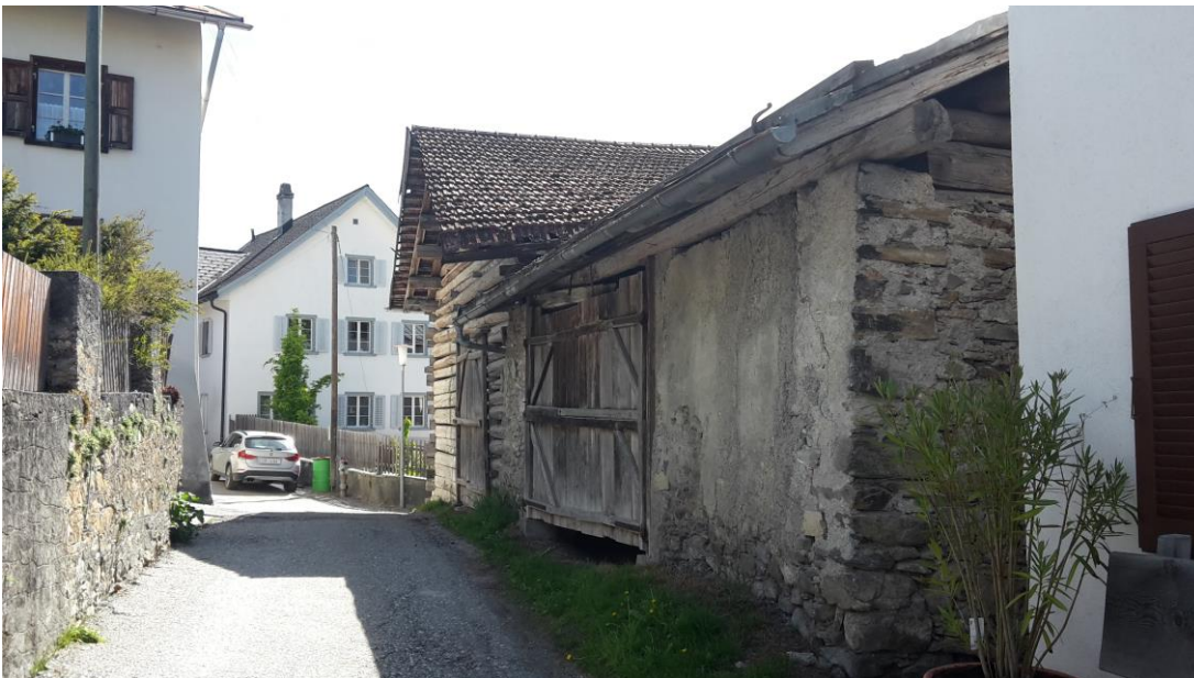
Im Anbau (rechts) des Türralstalles ereignete sich der Schadenfall.
