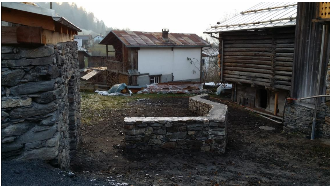
Die sanierte Bruchsteinmauer im Bongert des Jooshuus
