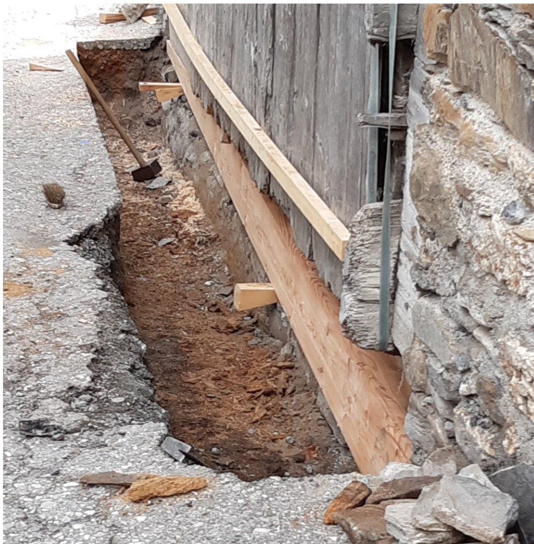
Ersetzen der angefaulten Balken auf der Seite der Freisserstrasse
