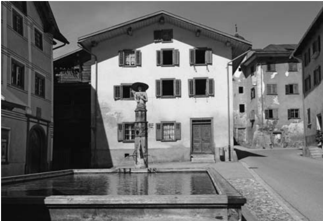
Das Engihus am Dorfplatz soll zu einem Gasthaus umgebaut werden.
