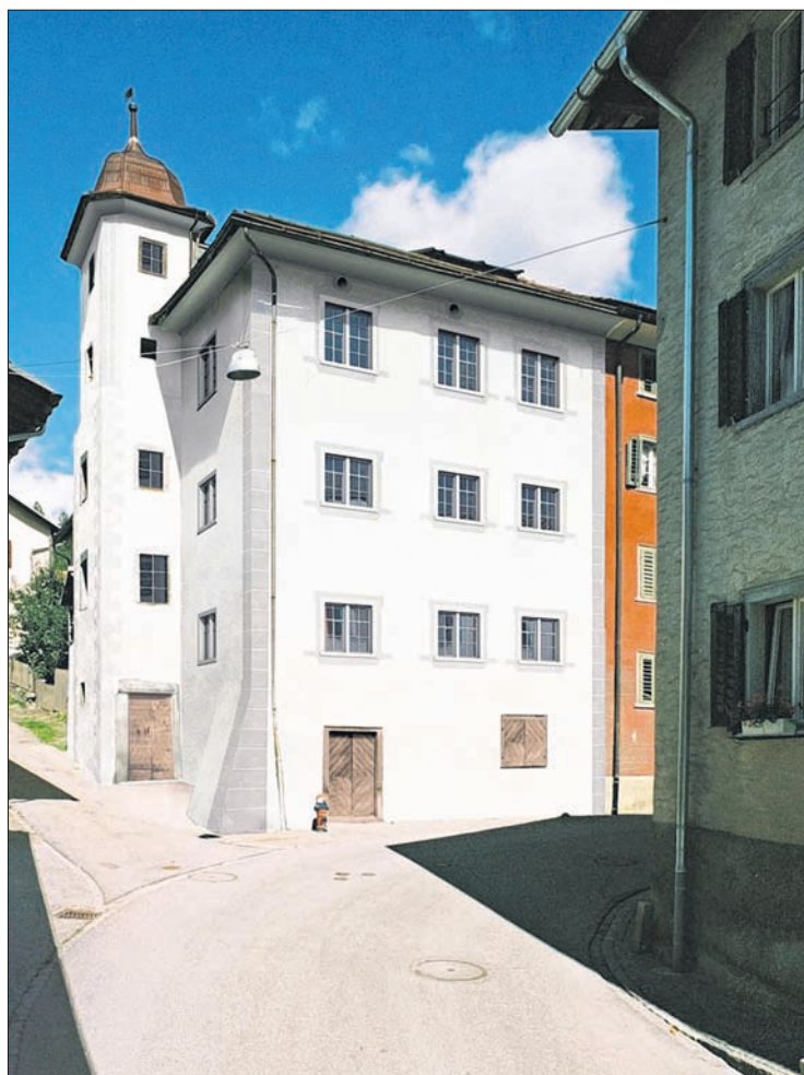
Neue Fassade: So könnte sich das Türralihuus einst von aussen präsentieren. (Bild zVg)
