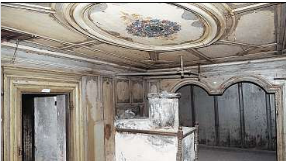
Blick ins Innere: Die alte Bausubstanz soll erhalten werden.
