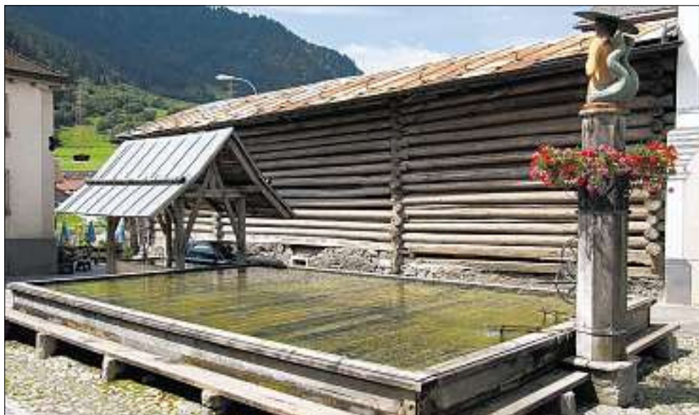
Der längste Holzbrunnen Europas, der in Valendas steht, wird diesen Winter neu gebaut.
