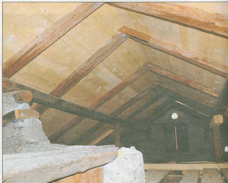
Blick unter das Dach, welches neu erstellt wurde.
