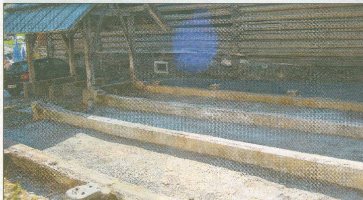
Derzeit sind nur noch die Betonsockel des grössten Holzbrunnens Europas ersichtlich. Bild bw
