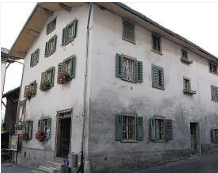
Das Engihuus soll schon bald in neuem Glanz erstrahlen.
