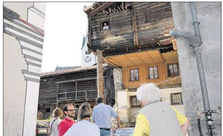
Die Gäste zeigten grosses Interesse für die nichtalltägliche Baustelle.
