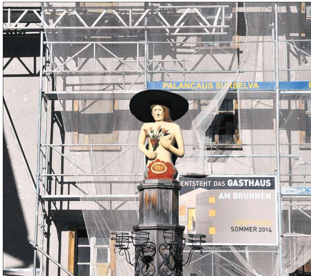
Die Arbeiten für das neue «Gasthaus am Brunnen» laufen auf Hochtouren.
