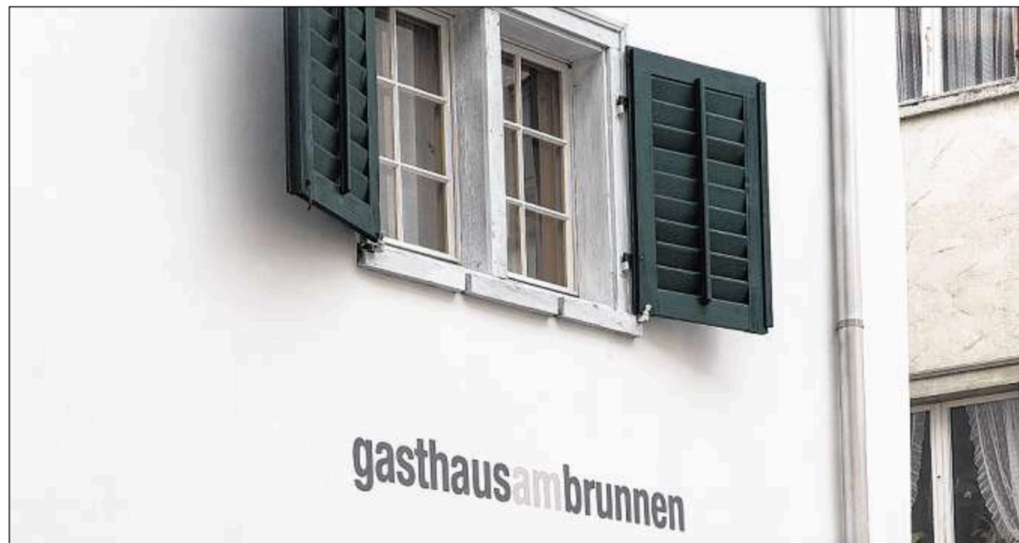
Heute sind alle eingeladen, sich das neue «Gasthaus am Brunnen» in Valendas anzuschauen – und morgen zur offiziellen Eröffnungsfeier. Bild zVg
