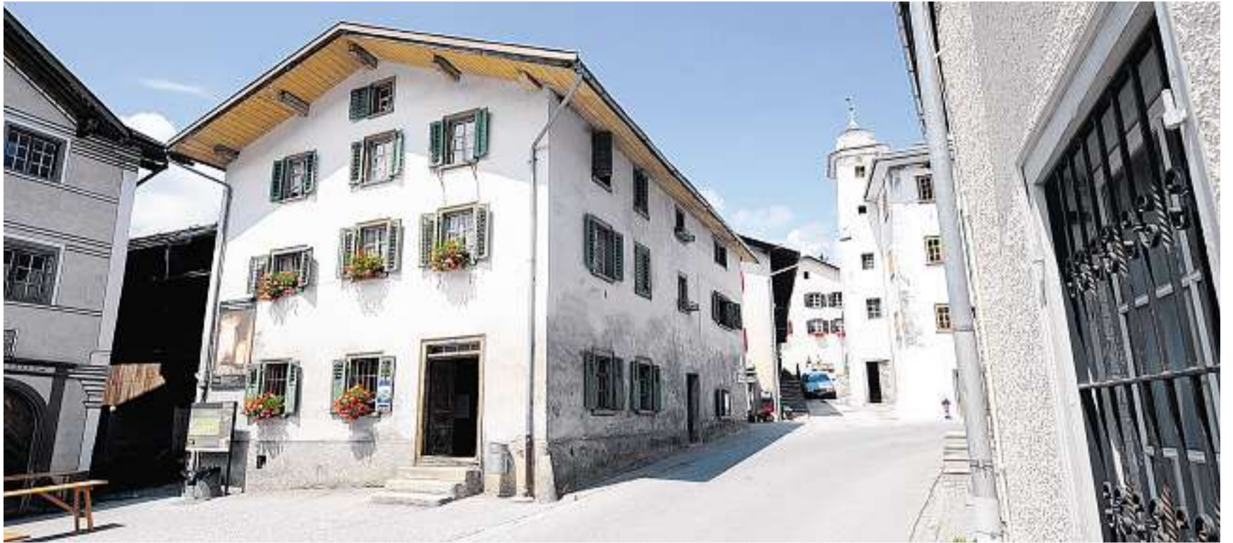
Viel zu tun: Das Engihuus harrt der Restaurierung; das Türralihuus (hinten rechts) hat bereits eine frische Fassade.
