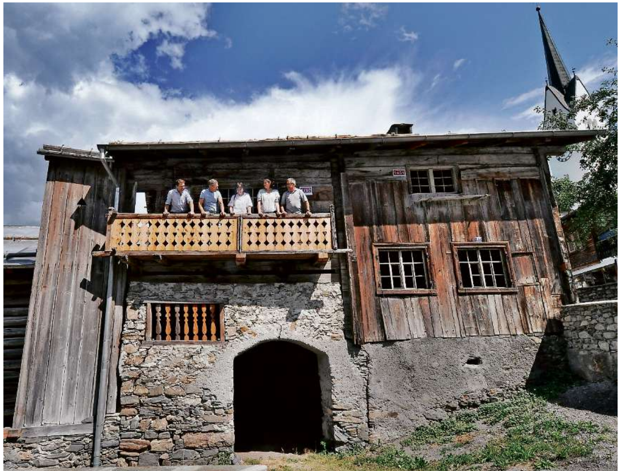
Sorgfältig konserviert und gesichert: Das Jooshus in Valendas kann nun ohne Eile einer neuen Nutzung harren.
